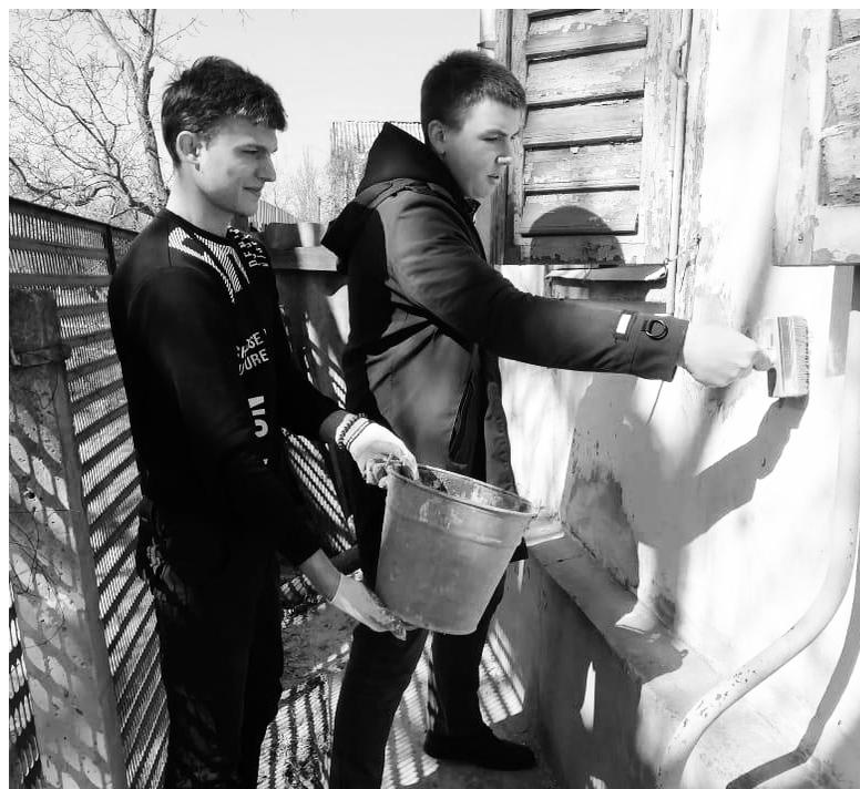
ющих построек, чтобы устранить протечку дома при дожде. В это же время, студенты строительного курса техникума ПАТИС расчищали обвалившуюся часть и специальным раствором выводили новую, чтобы избежать повторной обвалки стены. После полного высыхания смеси волонтеры приступили к побелке отремонтированных участков. Студентами также был отремонтирован порог входа в сарай.
